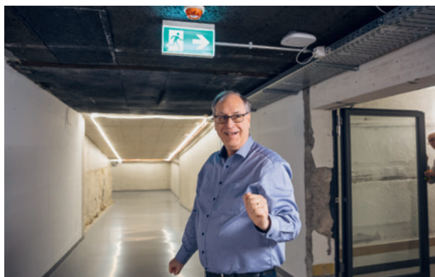
Markus Enz im unterirdischen Verbindungssystem des Kantonsspitals St.Gallen
